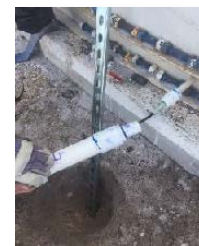
4. INSTALLING ER PROBE
