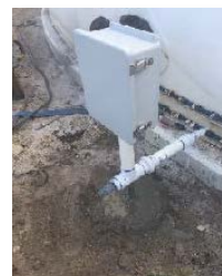
5. ER PROBE ENCLOSURE A
