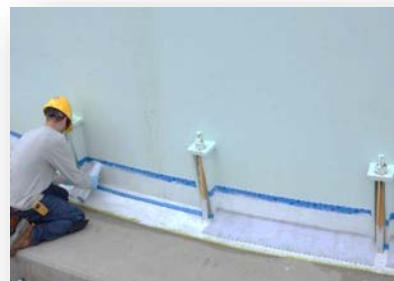
Applying Viscotaq EZ Wrap
